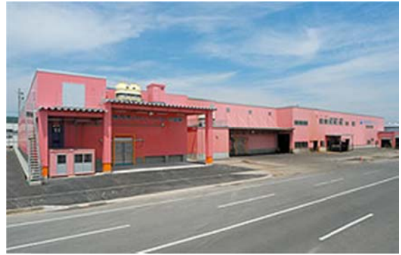
工事名：内源ジャパン冷蔵庫増築工事&内源ジャパン工場新築工事 所在地：石巻市魚町 竣工年：H19 発注者：(株)内源ジャパン 工事概要：S造 2F 備考：設計施工
