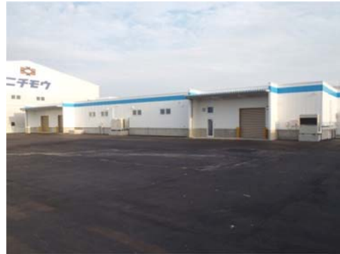
工事名：有限会社ミノリフーズ魚町工場新築工事 所在地：石巻市魚町 竣工年：H24 発注者：(有)ミノリフーズ 工事概要：木造 平屋 備考：設計施工
