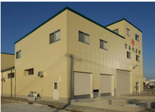
工事名：宮本水産(株)魚町本社工場震災復興工事 所在地：石巻市魚町 竣工年：H24 発注者：宮本水産(株) 工事概要：S造 平屋（一部3F） 備考：設計施工
