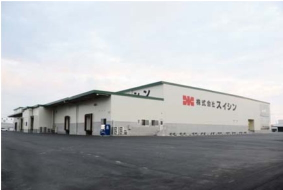
工事名：(株)スイシン本社・工場 震災復興工事 所在地：石巻市魚町 竣工年：H24 発注者：(株)スイシン 工事概要：S造 2F 備考：設計施工
