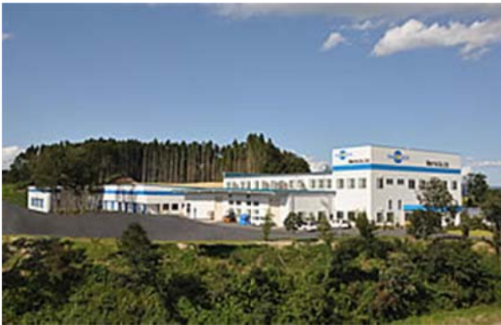
工事名：東北電子工業(株)河南北村工場新築工事 & (株)モリス本社建設工事 所在地：石巻市北村 竣工年：H21 発注者：東北電子工業(株) 工事概要：S造 平屋 備考：
