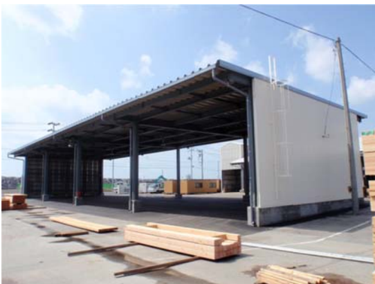
工事名：天龍木材(株)石巻支店ストックヤード新築工事 所在地：石巻市潮見町 竣工年：H24 発注者：天龍木材(株) 工事概要：S造 平屋 備考：設計施工
