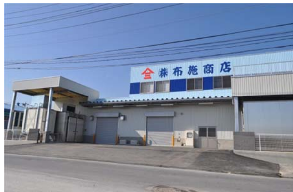
工事名：布施商店復興工事 所在地：石巻市魚町 竣工年：H24 発注者：(株)布施商店 工事概要：S造 2F 備考：設計施工
