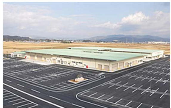
工事名：新石巻青果花き地方卸売市場建設工事 所在地：東松島市赤井 竣工年：H21 発注者：(株)石巻青果 工事概要：S造 平屋 備考：設計施工
