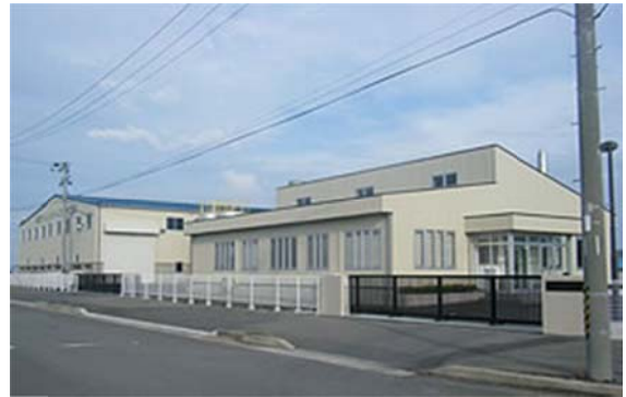
工事名：協同フィッシュミール工業石巻工場建設工事 所在地：石巻市魚町 竣工年：H19 発注者：協同フィッシュミール工業(株) 工事概要：S造 平屋 備考：
