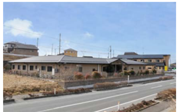
工事名：適合高齢者専用賃貸住宅「すえの里」新築工事&グループホーム「しらさぎ苑」新築工事 所在地：石巻市須江 竣工年：H22 発注者：(有)しらさぎ苑 工事概要：木造 2F 備考：設計施工
