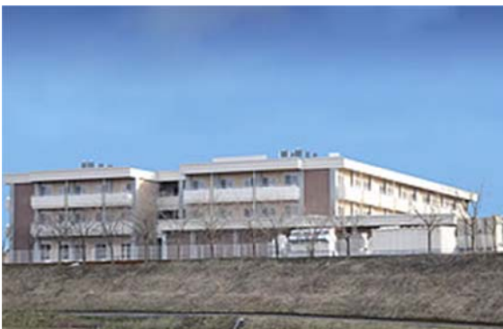
工事名：養護老人ホームきたかみ園建設工事 所在地：登米市登米町 竣工年：H21 発注者：社会福祉法人 登米福祉会 工事概要：RC造 3F 備考：
