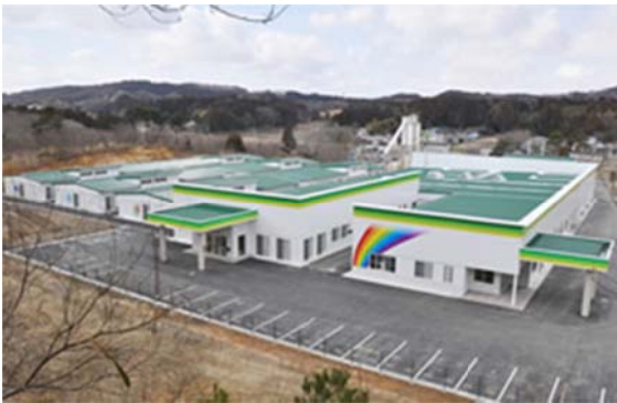
工事名：特別養護老人ホーム万葉苑新築工事 所在地：石巻市北村 竣工年：H23 発注者：社会福祉法人 向陽会 工事概要：S造 平屋 備考：
