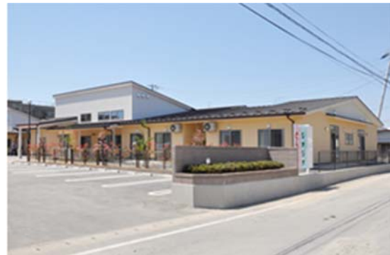
工事名：小規模多機能型居宅介護施設びかびか新築工事 所在地：石巻市住吉町 竣工年：H23 発注者：(有)緑三松 工事概要：木造 平屋 備考：設計施工
