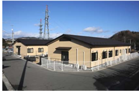
工事名：グループホームなんてんおがつ新築工事 所在地：石巻市小船越 竣工年：H23 発注者：(有)フレンズ 工事概要：木造 平屋 備考：設計施工
