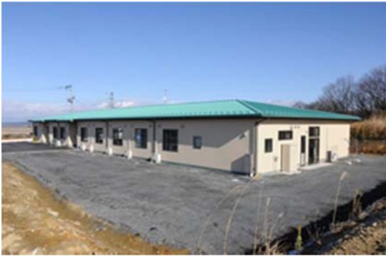
工事名：適合高齢者専用賃貸住宅「やすらぎの里」 & デイサービスセンター「めんこい」新築工事 所在地：石巻市須江 竣工年：H23 発注者：(有)しらすぎ苑 工事概要：木造 平屋 備考：
