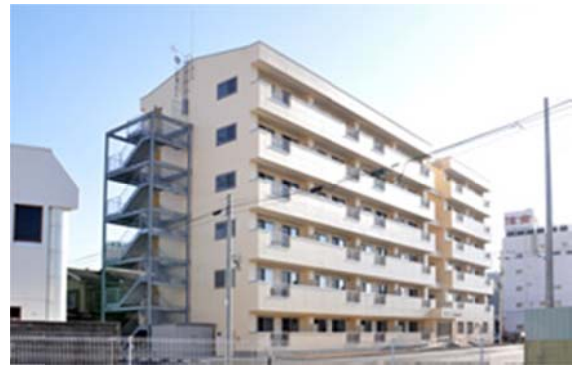
工事名：高齢者優良賃貸住宅「華心」新築工事 所在地：石巻市中央 竣工年：H23 発注者：(株)エムティシー 工事概要：S造 6F 備考：設計施工
