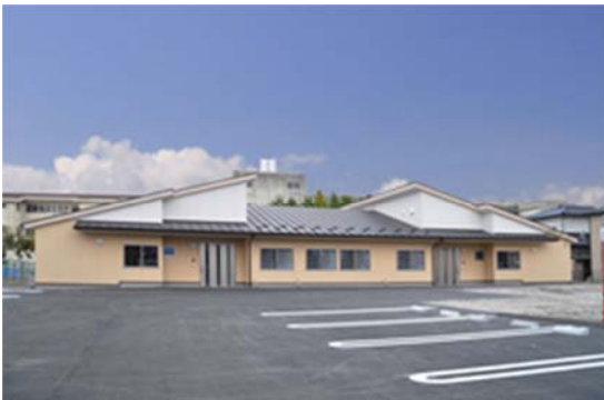
工事名：グループホームぐらんす新築工事 所在地：石巻市住吉町 竣工年：H22 発注者：(有)緑三松 工事概要：木造 平屋 備考：設計施工
