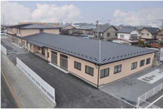
工事名：適合高齢者専用賃貸住宅「グレース築山」新築工事 所在地：石巻市築山 竣工年：H23 発注者：(有)建翔 工事概要：木造 2F 備考：設計施工
