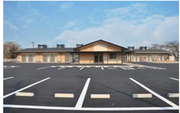
工事名：地域密着型特別養護老人ホームゆりの郷新築工事 所在地：登米市登米町 竣工年：H23 発注者：社会福祉法人 恵泉会 工事概要：木造 平屋 備考：
