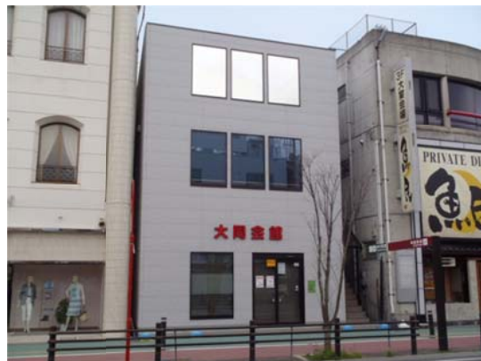
工事名：大同会館新築工事 所在地：石巻市穀町 竣工年：H23 発注者：(有)大同会館 工事概要：木造 3F 備考：設計施工
