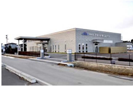
工事名：みどりのサービス葬祭会館新築工事 所在地：大崎市鹿島台 竣工年：H22 発注者：全国農業協同組合連合会宮城県本部 工事概要：S造 平屋 備考：
